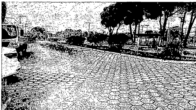
FIGURA 90 - TRECHO COM PAVIMENTAÇÃO EM BLOCOS INTERTRAVADOS - AVENIDA RENATO SOARES DOS REIS.
