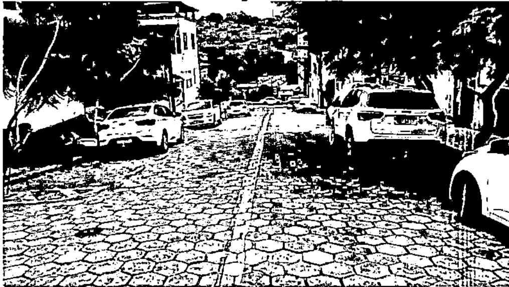
Figura 71 – Sinalização horizontal ideal e em bom estado de conservação - Rua Tito Cid Magalhães.
